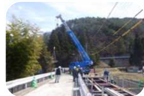
◇床版架設/Ⅰ期線
