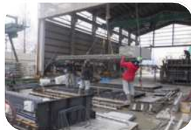
◇RC床版工場製作
