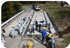
◇間詰めコンクリート打設/Ⅰ期線
