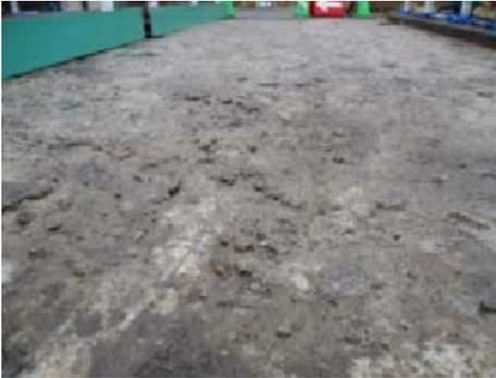
○床版内部に水平方向のひび割れが多く確認され、撤去つり上げ時には崩壊した。
