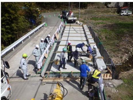
○超速硬コンクリート打設(3時間)30N/mm<sup>2</sup>強度発現(3時間)
